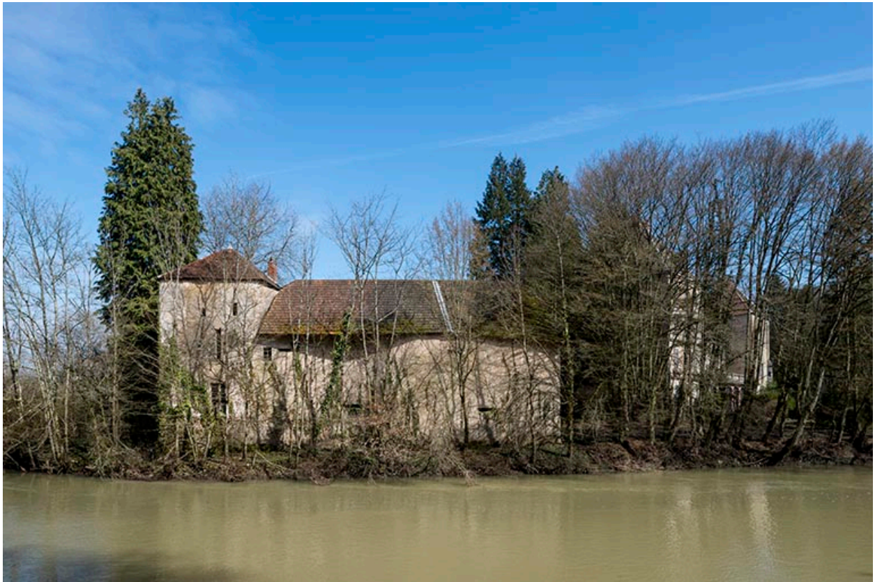
Communs du château, vue depuis la rue du Moulin rouge.
