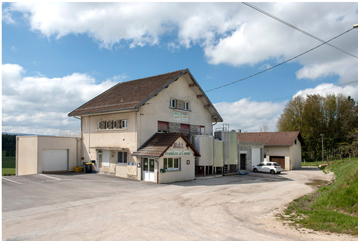
Façades antérieure et latérale gauche.
