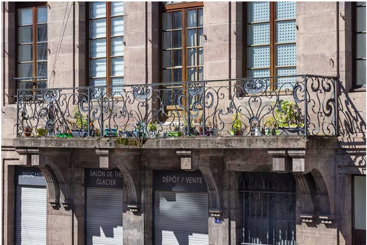
Maison Desgranges, façade est, balcon.
