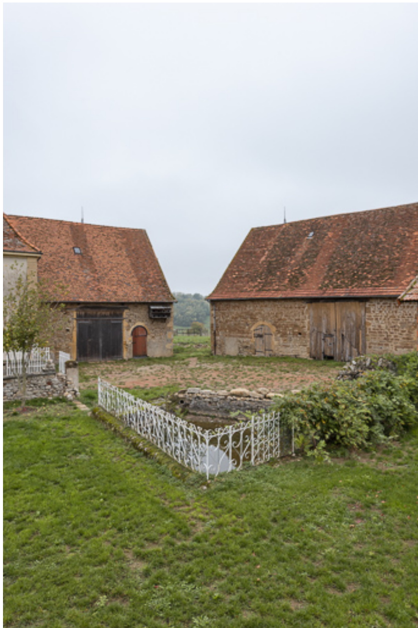
Vue depuis l'angle sud-est de la maison jusqu'à la grange, incluant le cuvage et la mare
