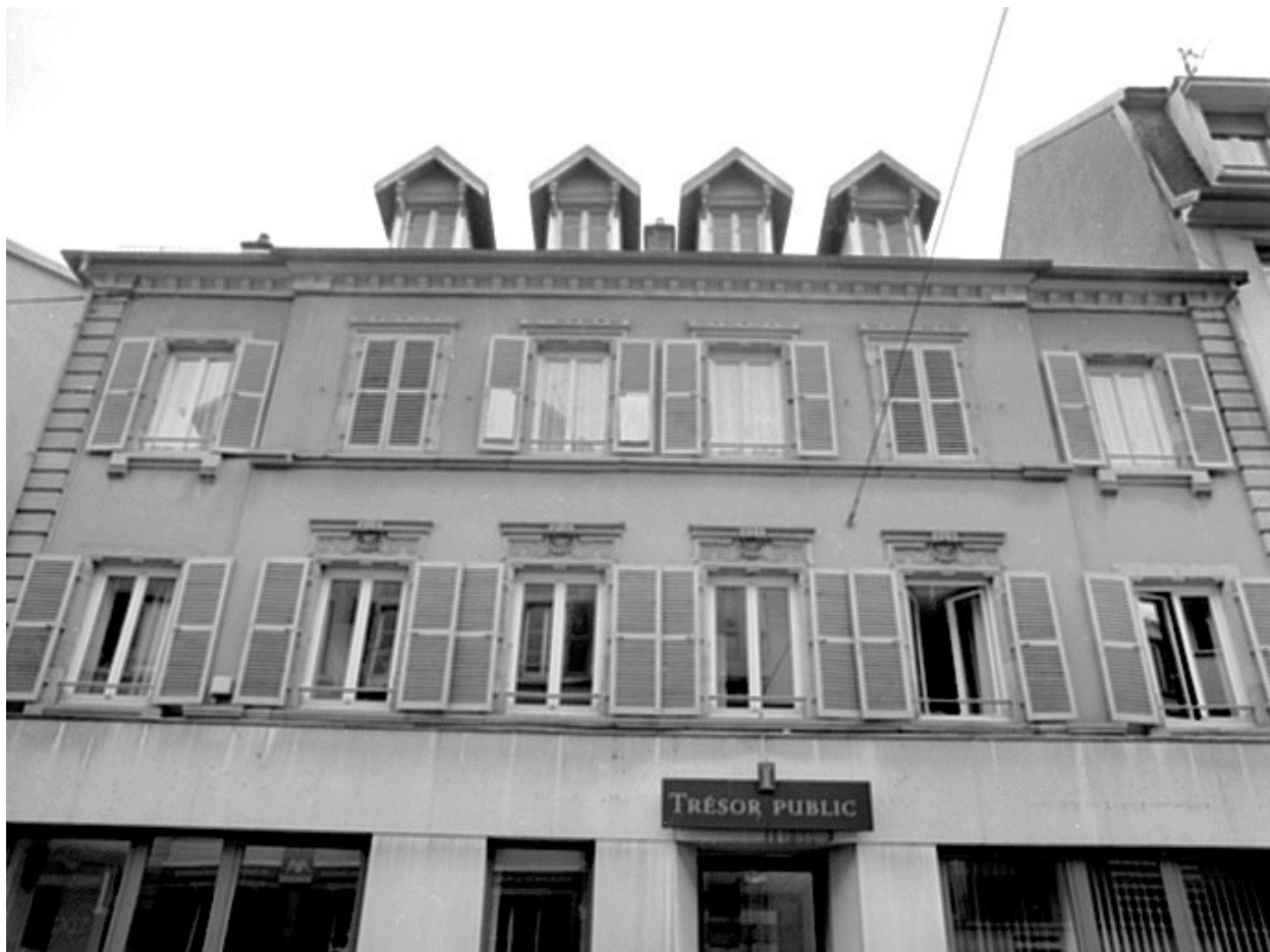
Etages du bâtiment sis au n° 25 (logements ?).
