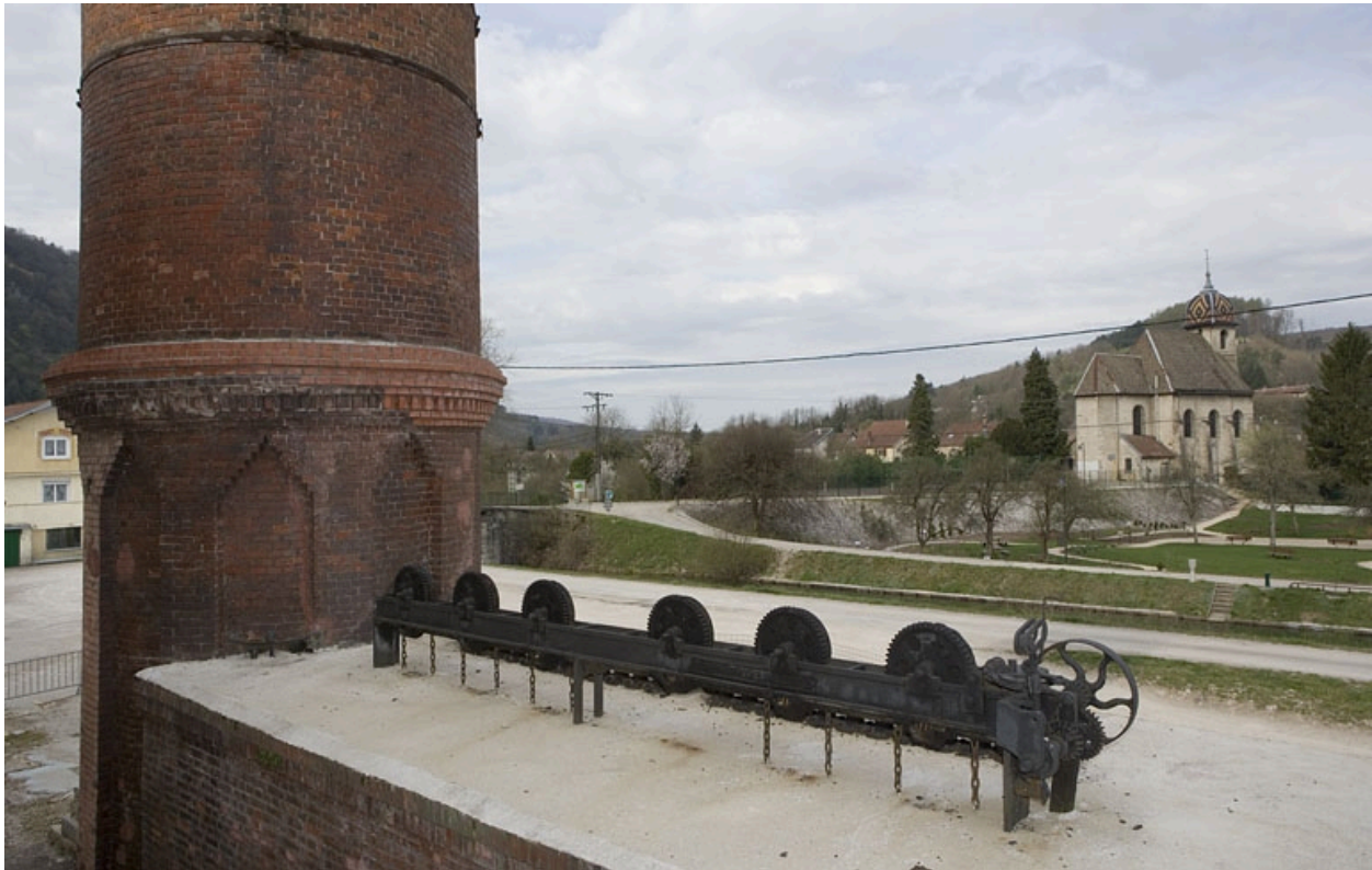
Système de levage des portes (?) de la chaudière.
