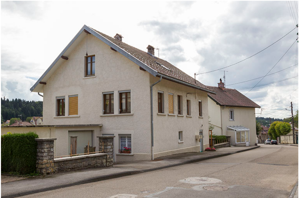
Façades antérieure et latérale gauche.
