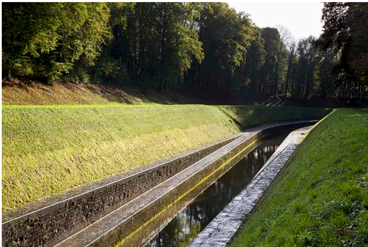
Le canal, vue aval.
