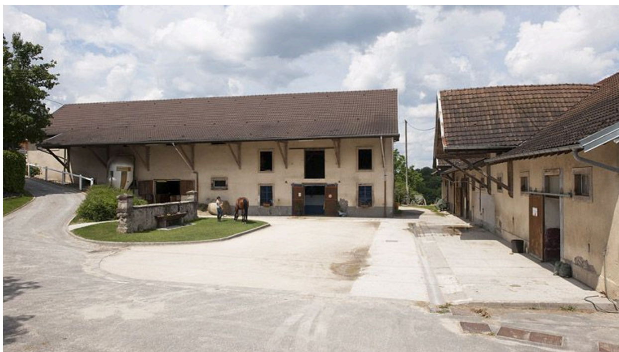
Cour de la ferme et bâtiments agricoles.
