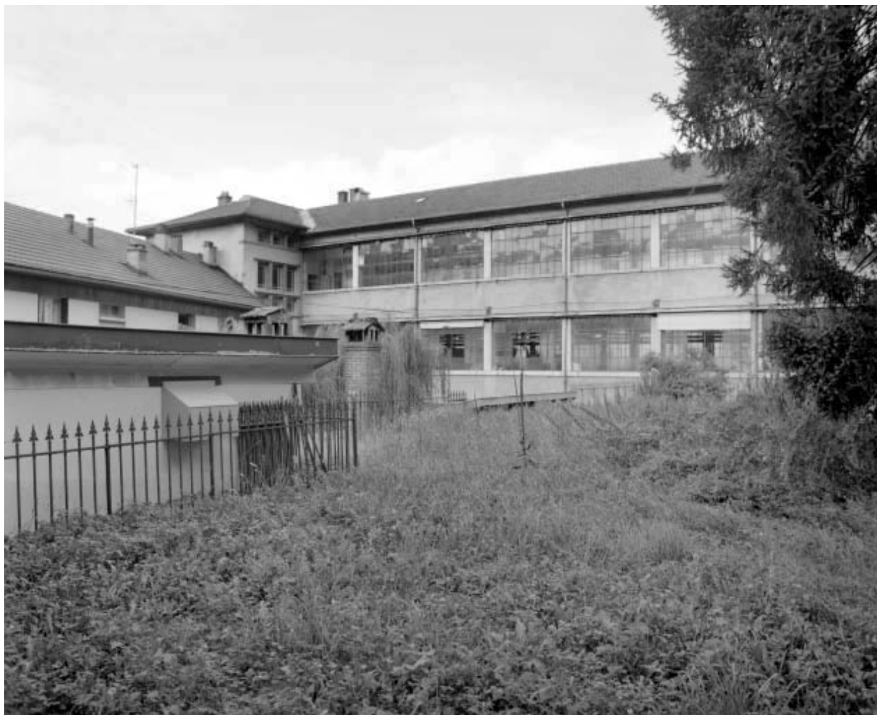
Façade latérale droite du 1er bâtiment.
