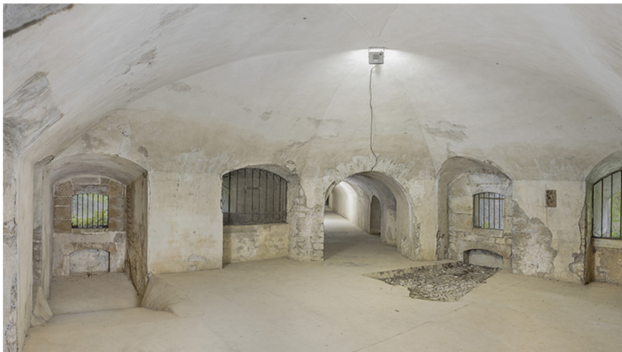
Vue intérieure de la double caponnière et sa gaine d'accès en arrière-plan.
