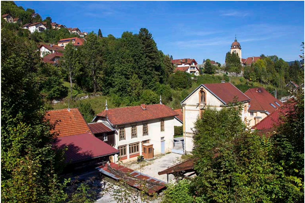
Vue d'ensemble plongeante, depuis le sud.
