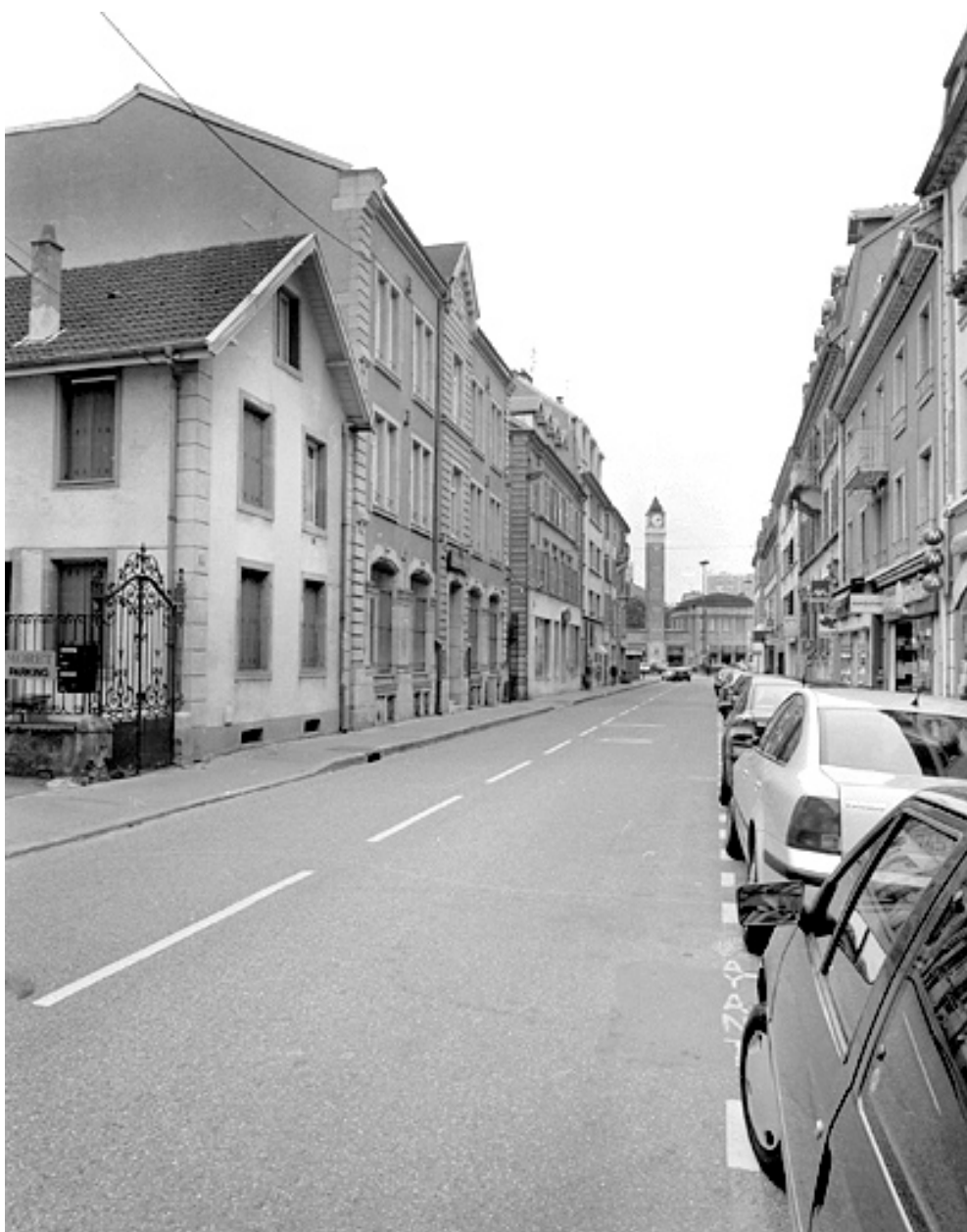
Façades sur rue depuis l'est.
