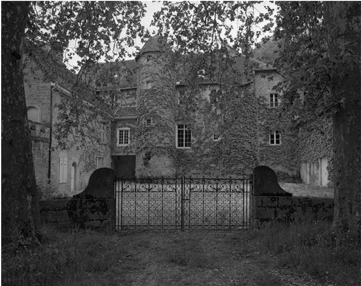
Façade sur cour et portail d'entrée.
