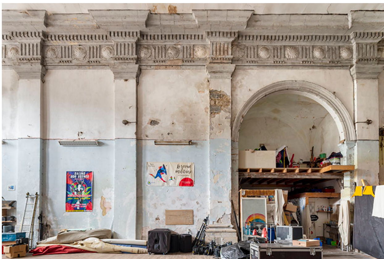
Elévation du mur nord de la chapelle.
