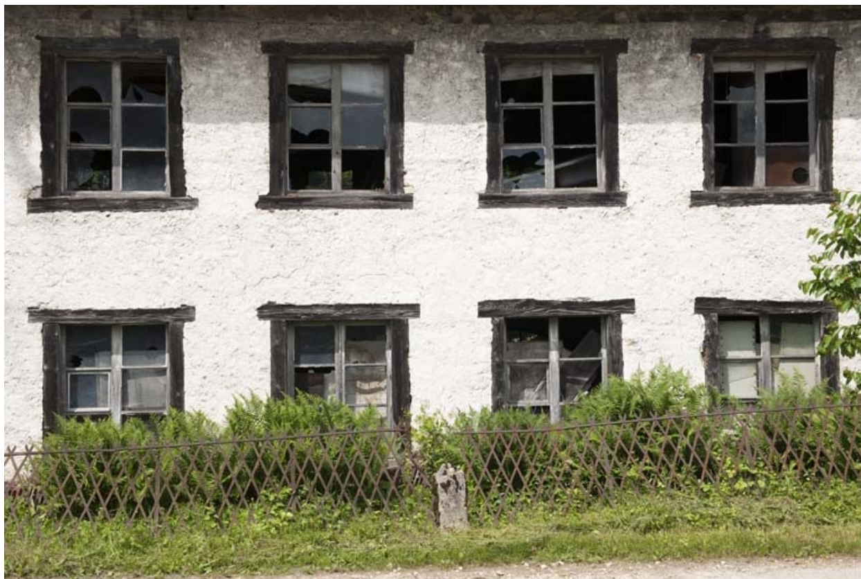
Détail de la façade est de l'atelier.
