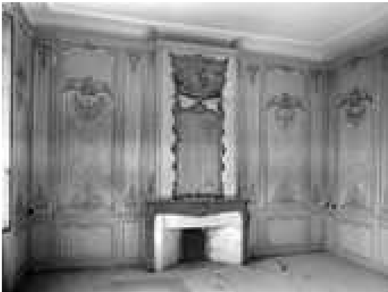
Logis sur cour, intérieur : vue d'ensemble de la cheminée du salon.
