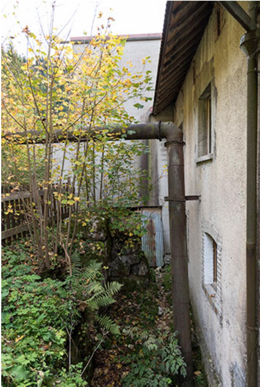
Atelier de fabrication : tuyau d'amenée d'eau de la turbine (façade postérieure).
