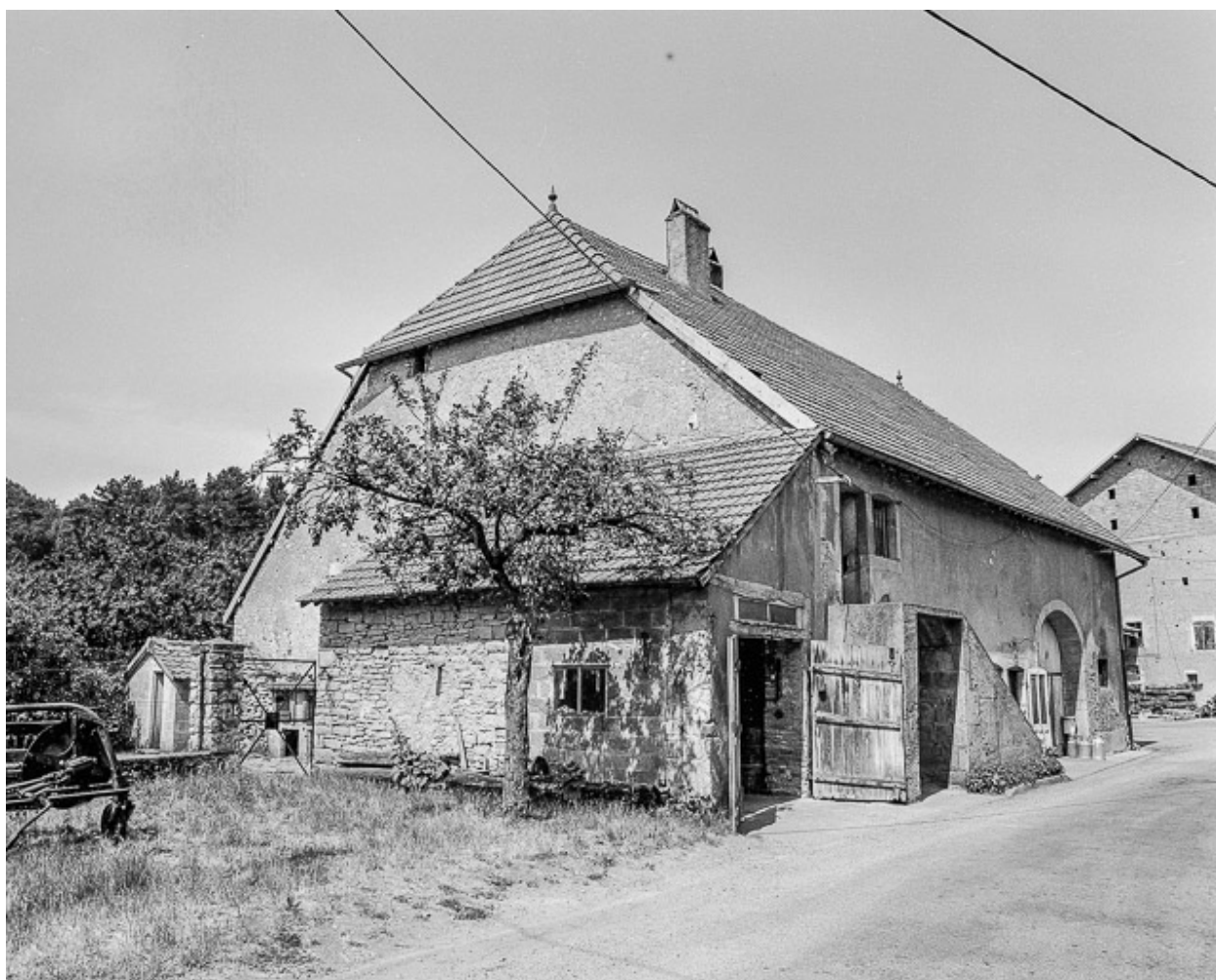
Ferme située entre la rue d'Amont et la rue de la Fontaine : Façade antérieure et façade latérale gauche.
