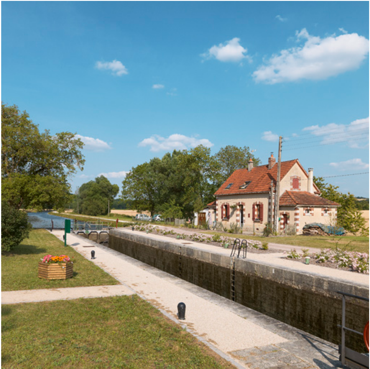
Vue d'aval du site d'écluse.
