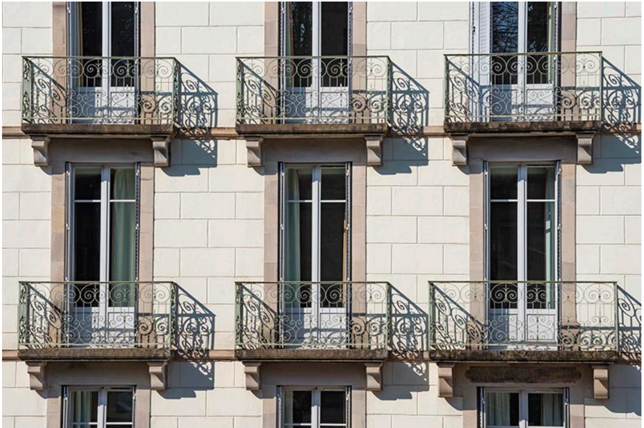
Façade sur rue de l'aile sud, détail : balcons.
