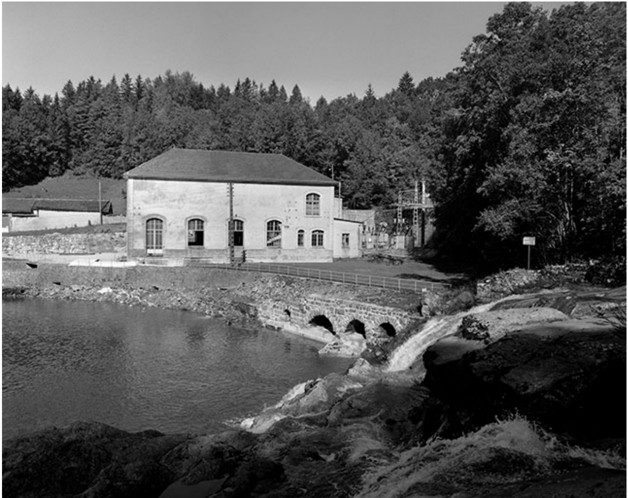
Vue d'ensemble de la centrale depuis la cascade.
