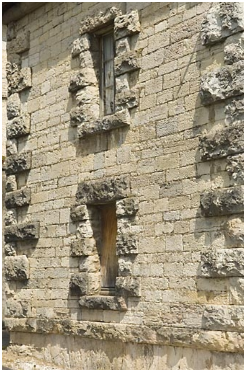
Travée de façade du logement ouvrier ouest.
