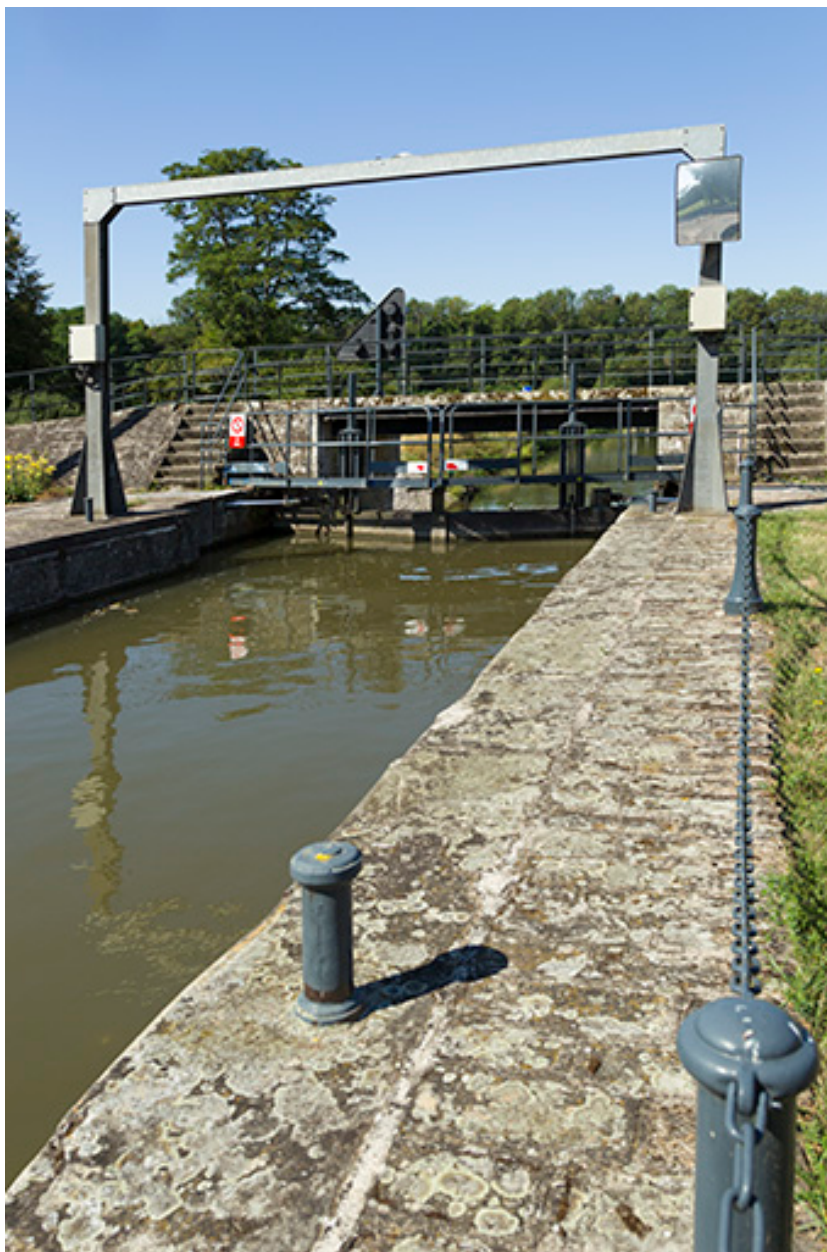
Vue sur un bajoyer et les portes en arrière plan.
