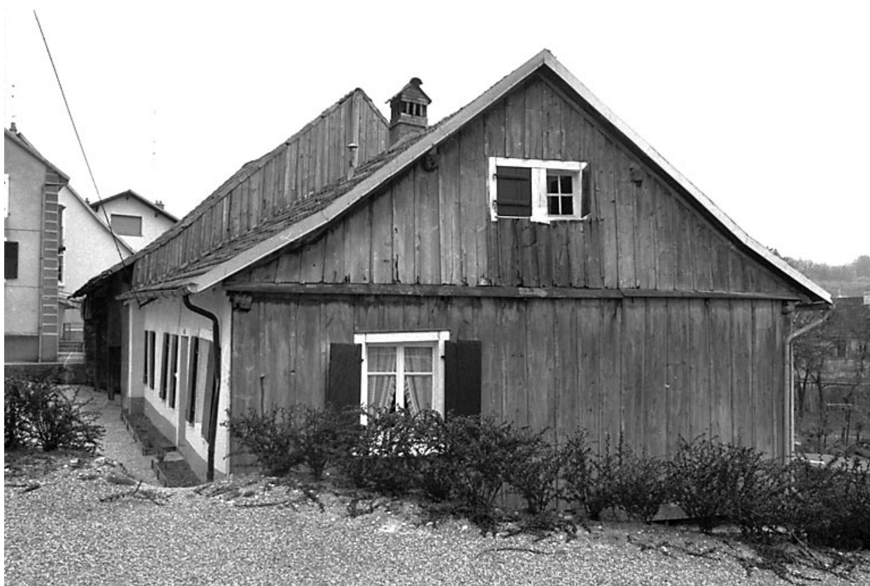
Vue du pignon droit.
