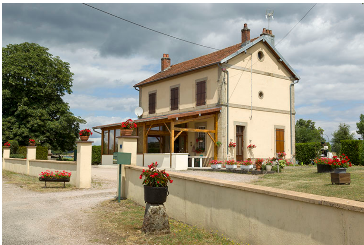
L'ancienne gare transformée en maison d'habitation.
