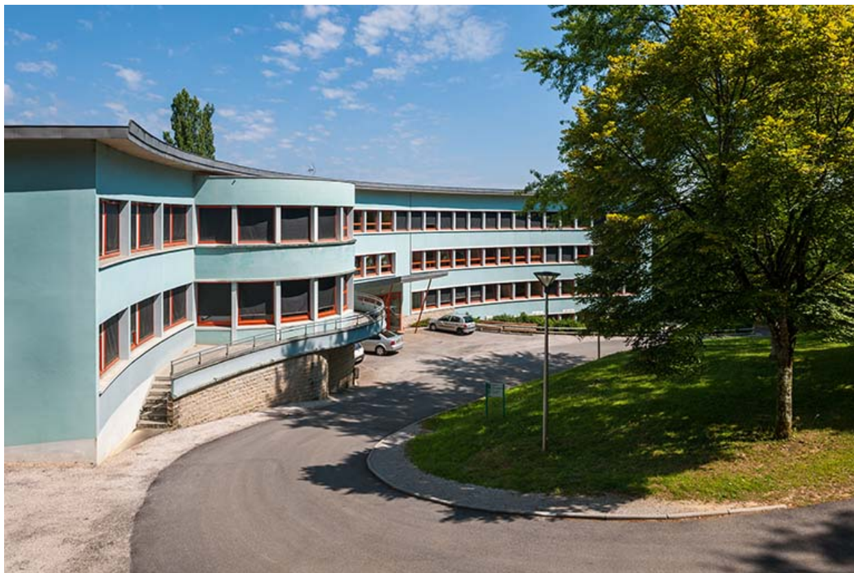
Internat : vue sud.
