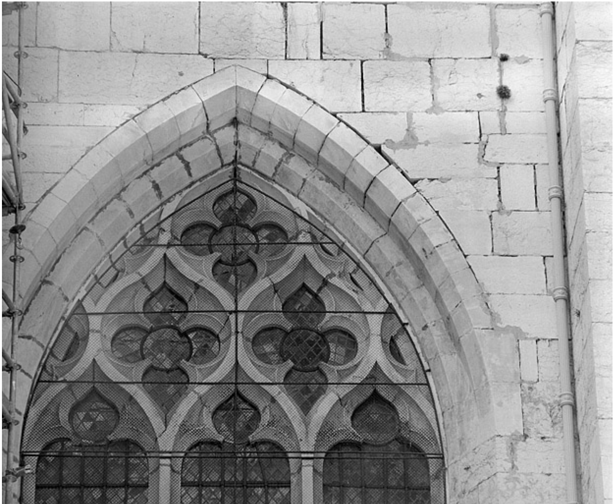
Détail de la baie nord de l'ancienne chapelle de Neuville.
