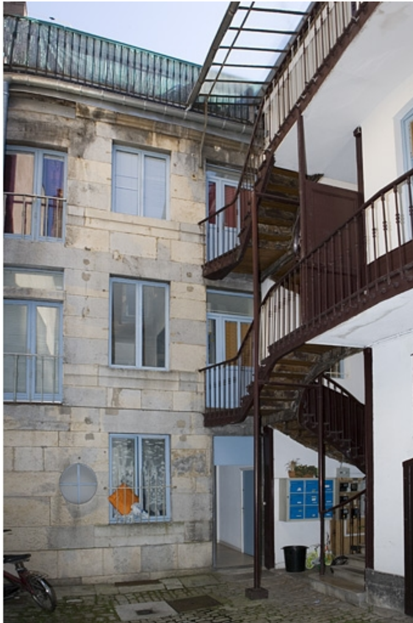
Façade antérieure du logis secondaire avec l'escalier à cage ouverte.
