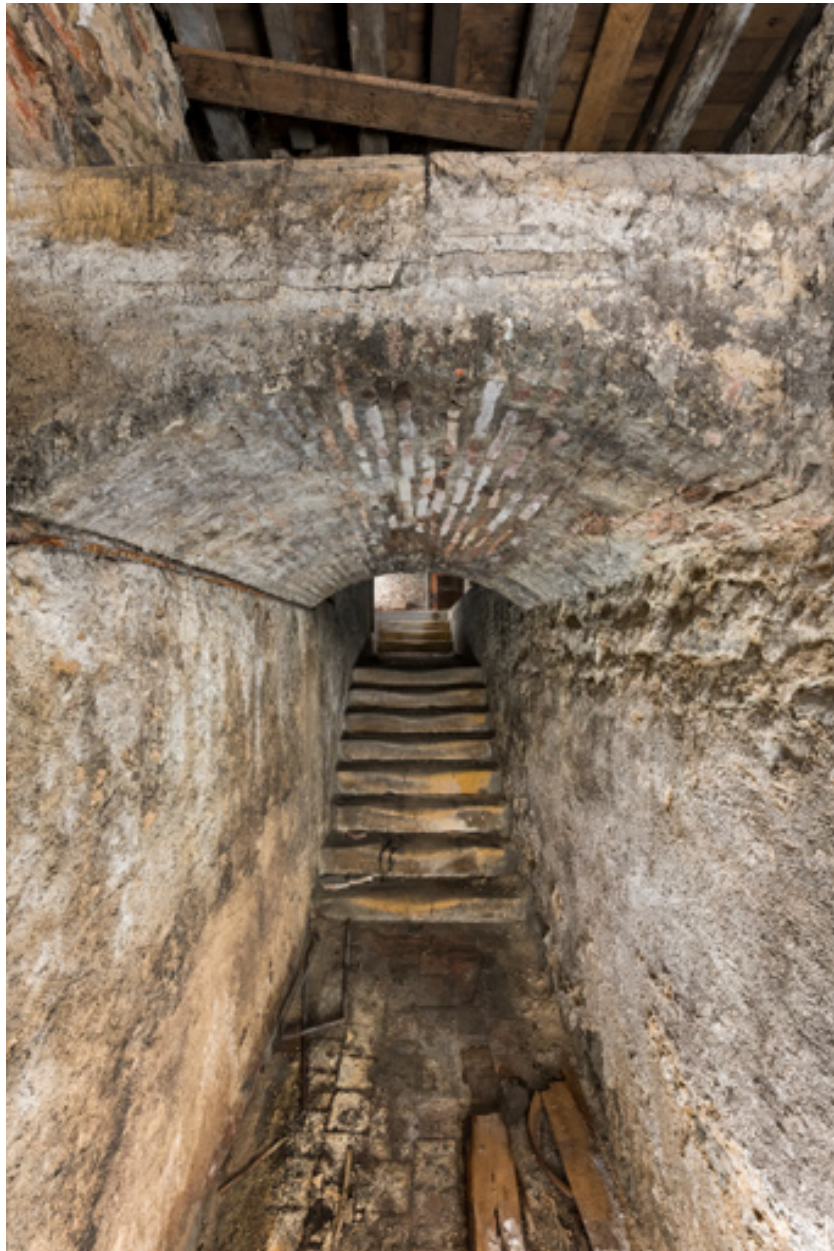
Couloir et escalier sous la salle.
