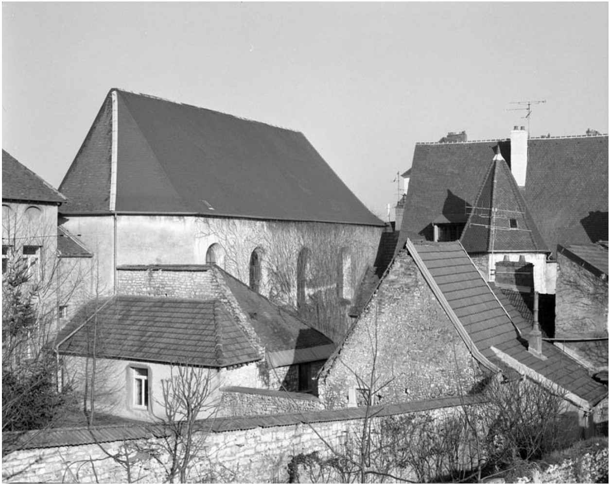
Chapelle : chevet et façade latérale gauche depuis l'arrière de l'hôtel de Conflans, vue rapprochée en 1989.
