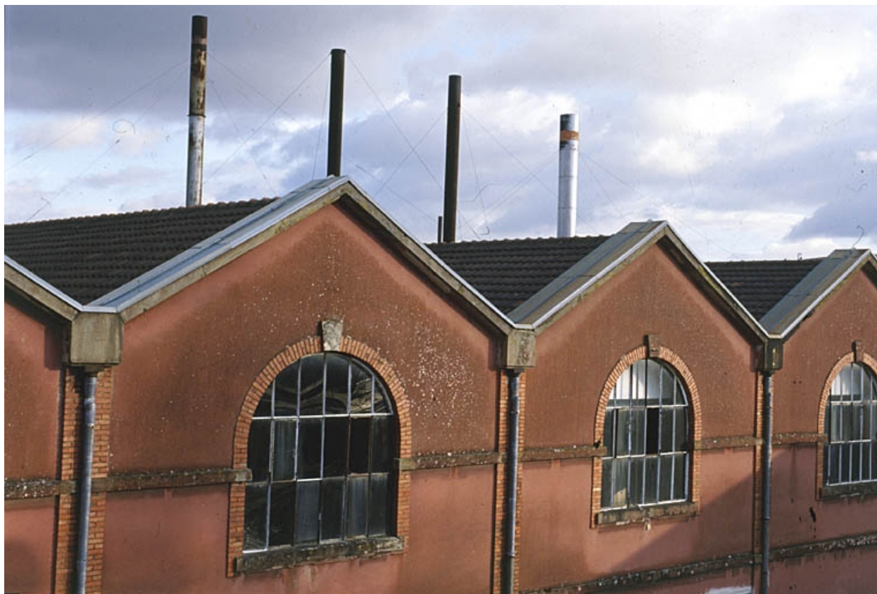
Chaufferie : façade ouest.
