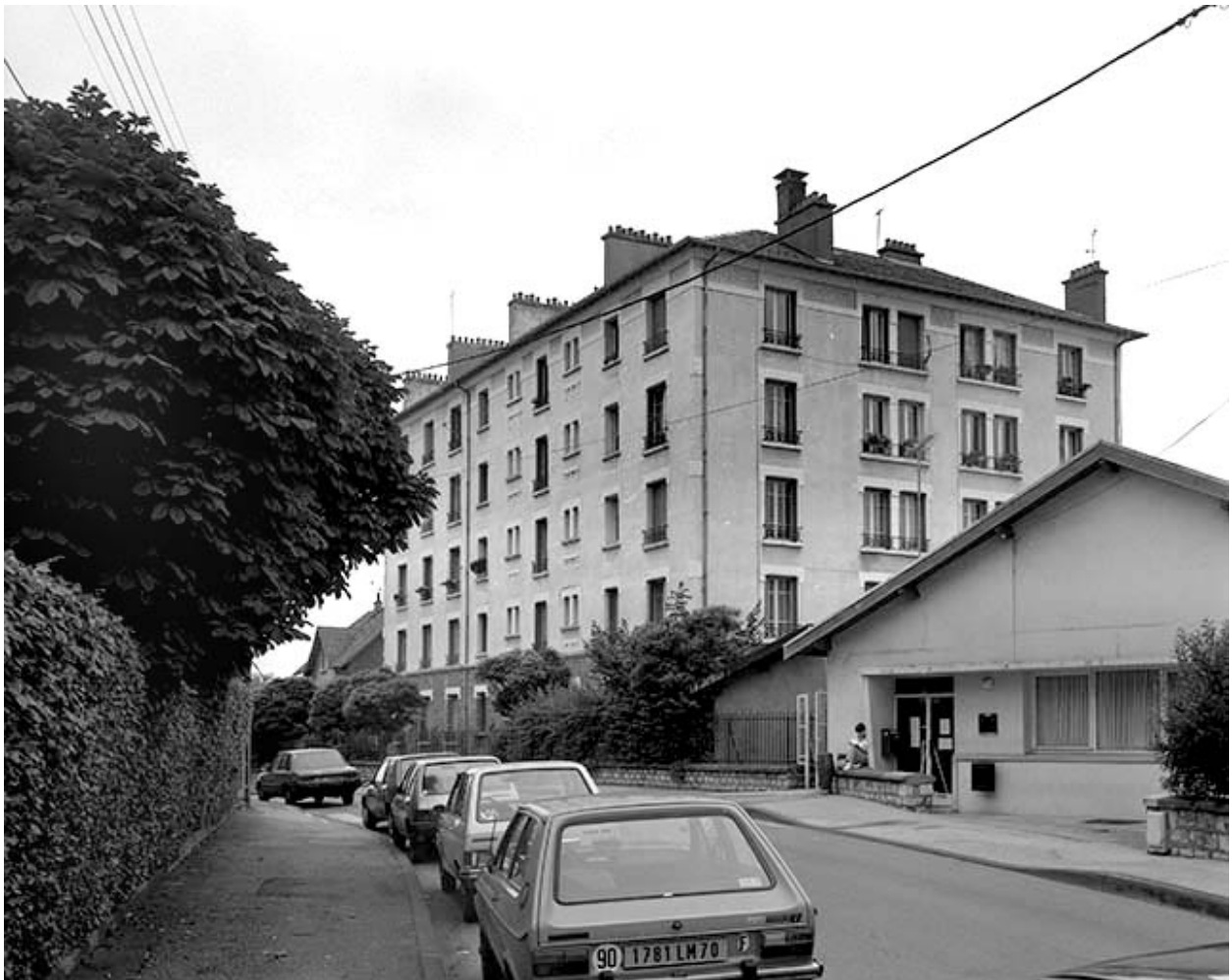
Immeuble, 50 avenue Georges Clémenceau.
