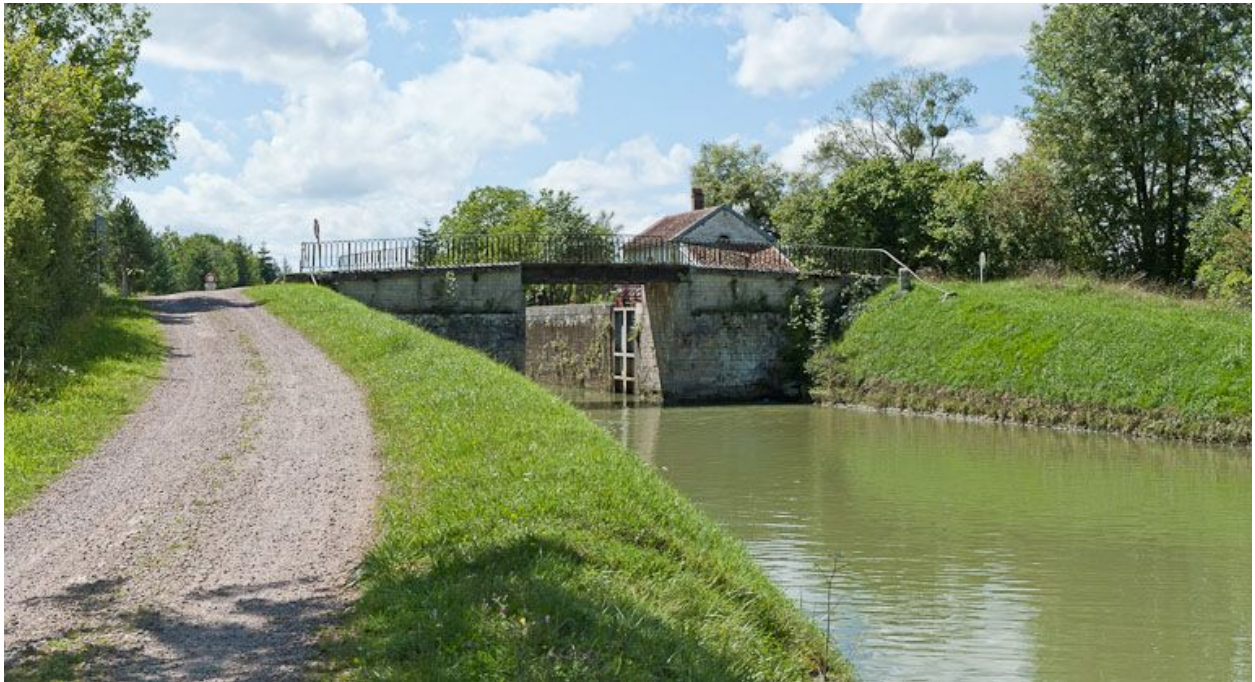
Vue du pont depuis l'aval.
