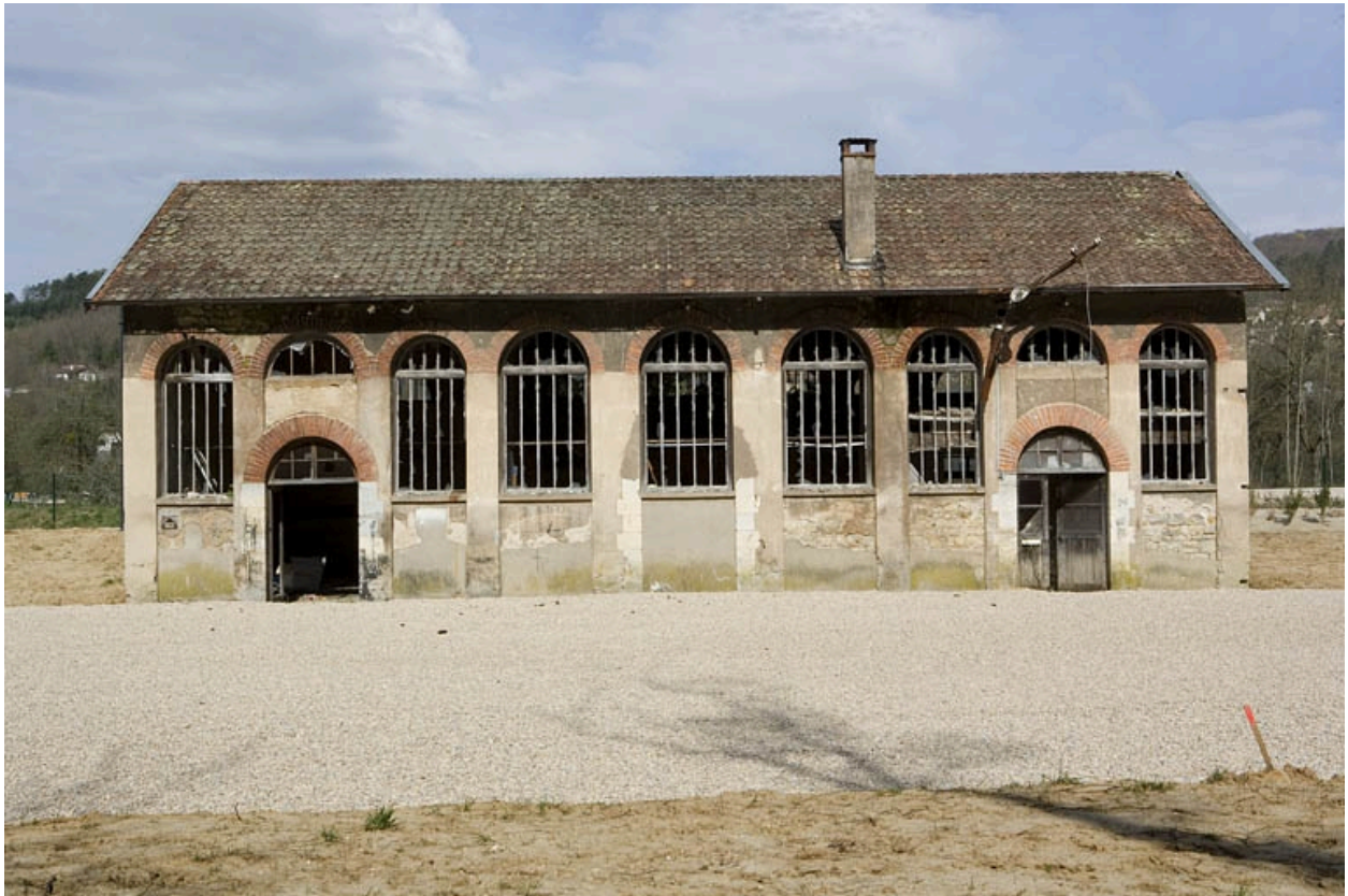
Façade est de l'atelier de réparation.
