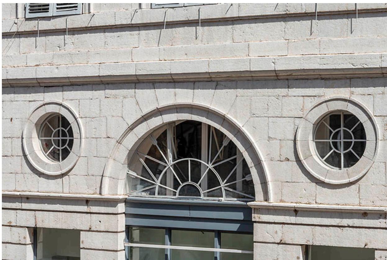
Façade antérieure. Ouvertures de l'entresol.
