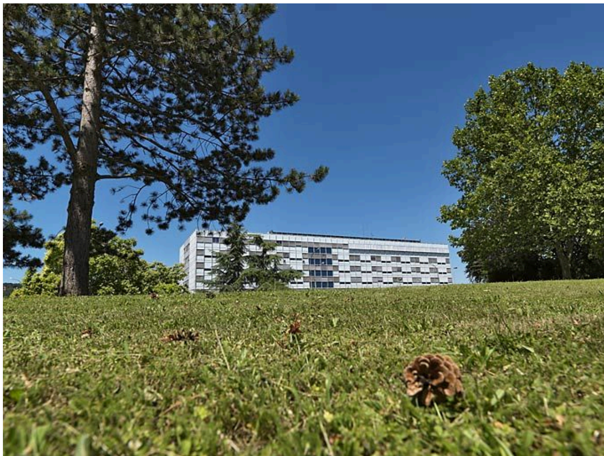
Bâtiment principal, vue d'ensemble.
