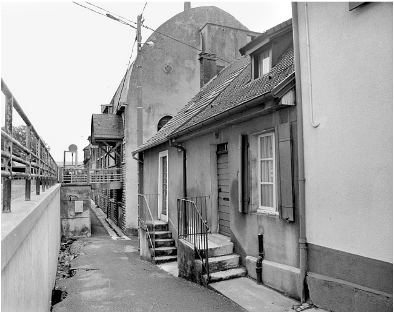
Maisons 1 et 3, rue des Potiers. 19e siècle.
