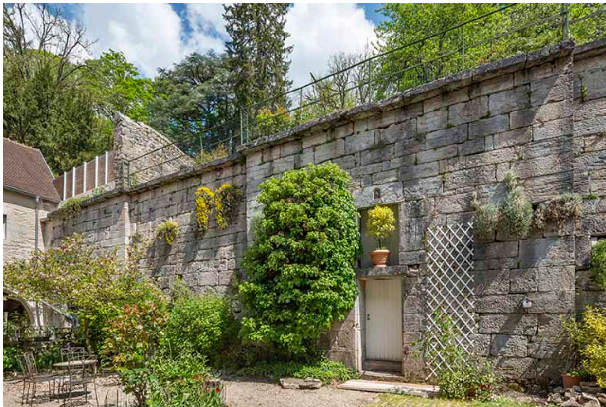
Mur de la terrasse en terre-plein.
