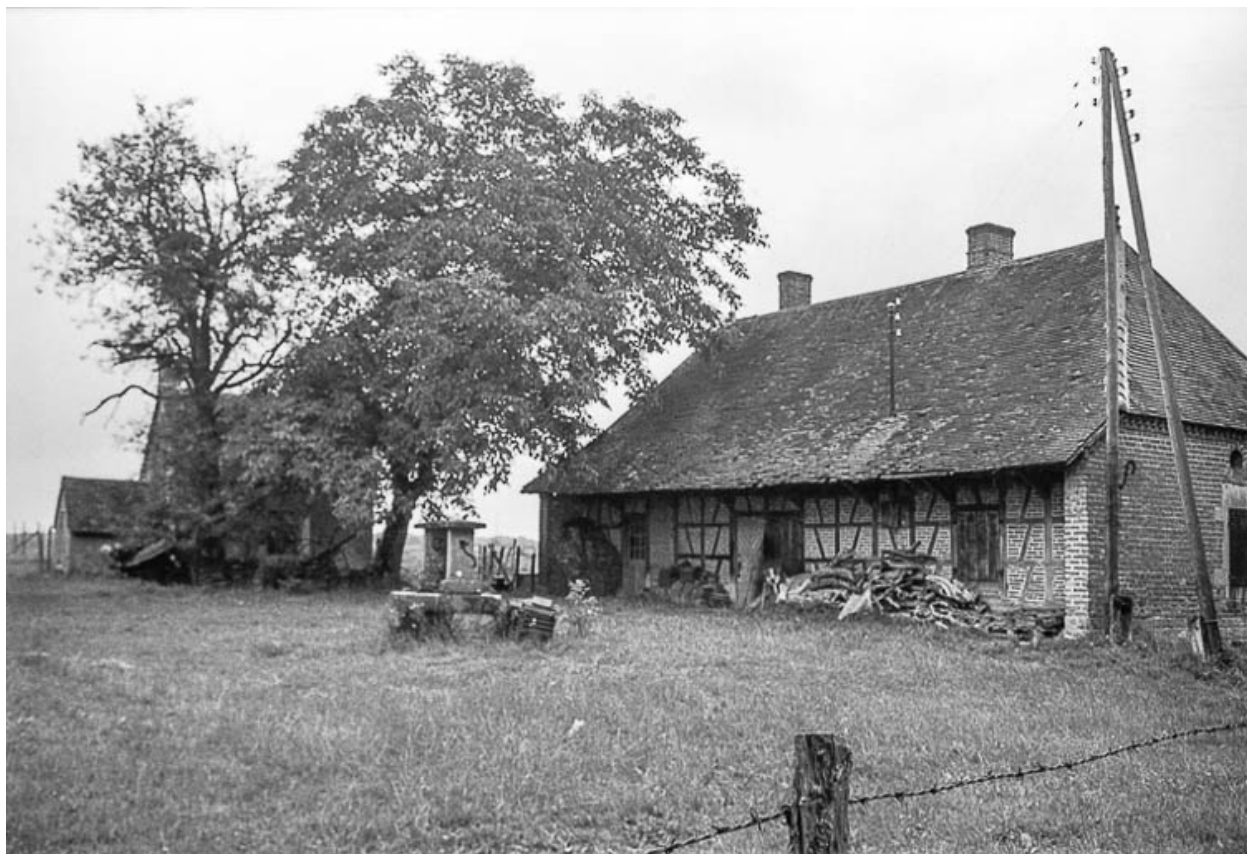
Façade antérieure du bâtiment d'habitation.
