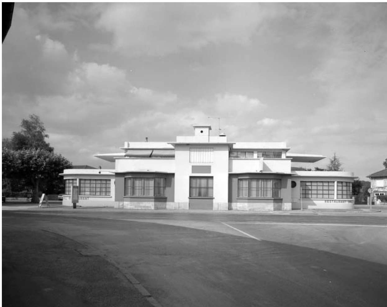
Vue d'ensemble de face.
