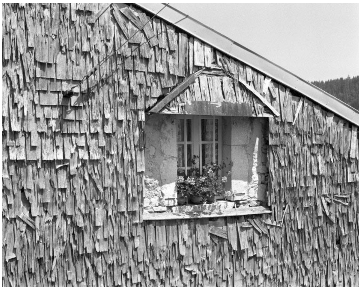
La fenêtre de la face gauche.
