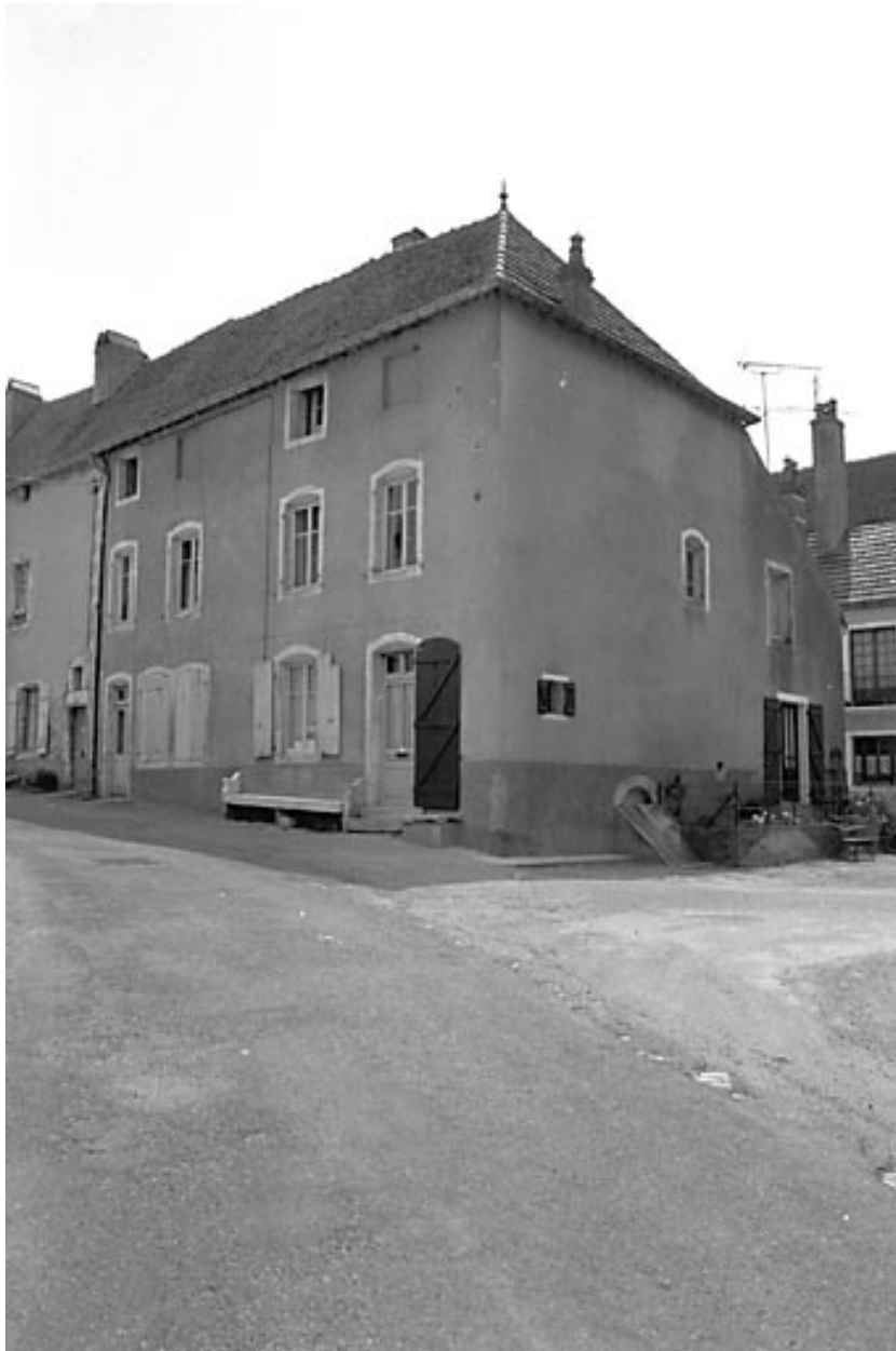
Maison située 7 rue Saint-Hilaire : vue d'ensemble.
