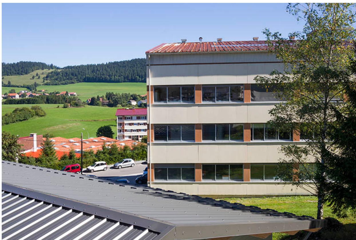
Corps nord : façade postérieure.
