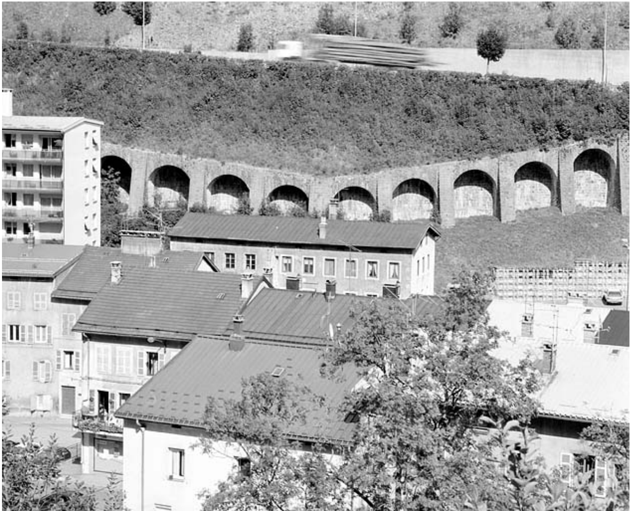
Mur à arcades, depuis l'ouest.
