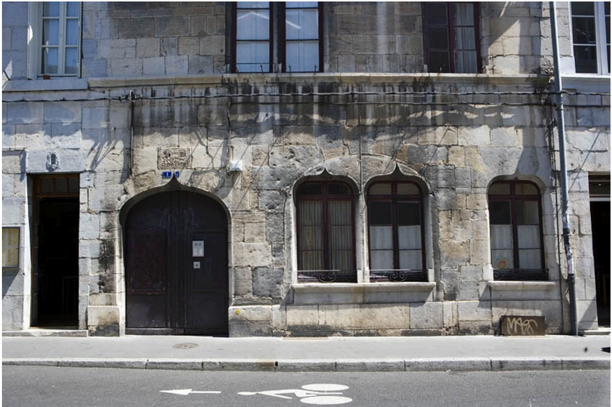
Détail du rez-de-chaussée sur rue.
