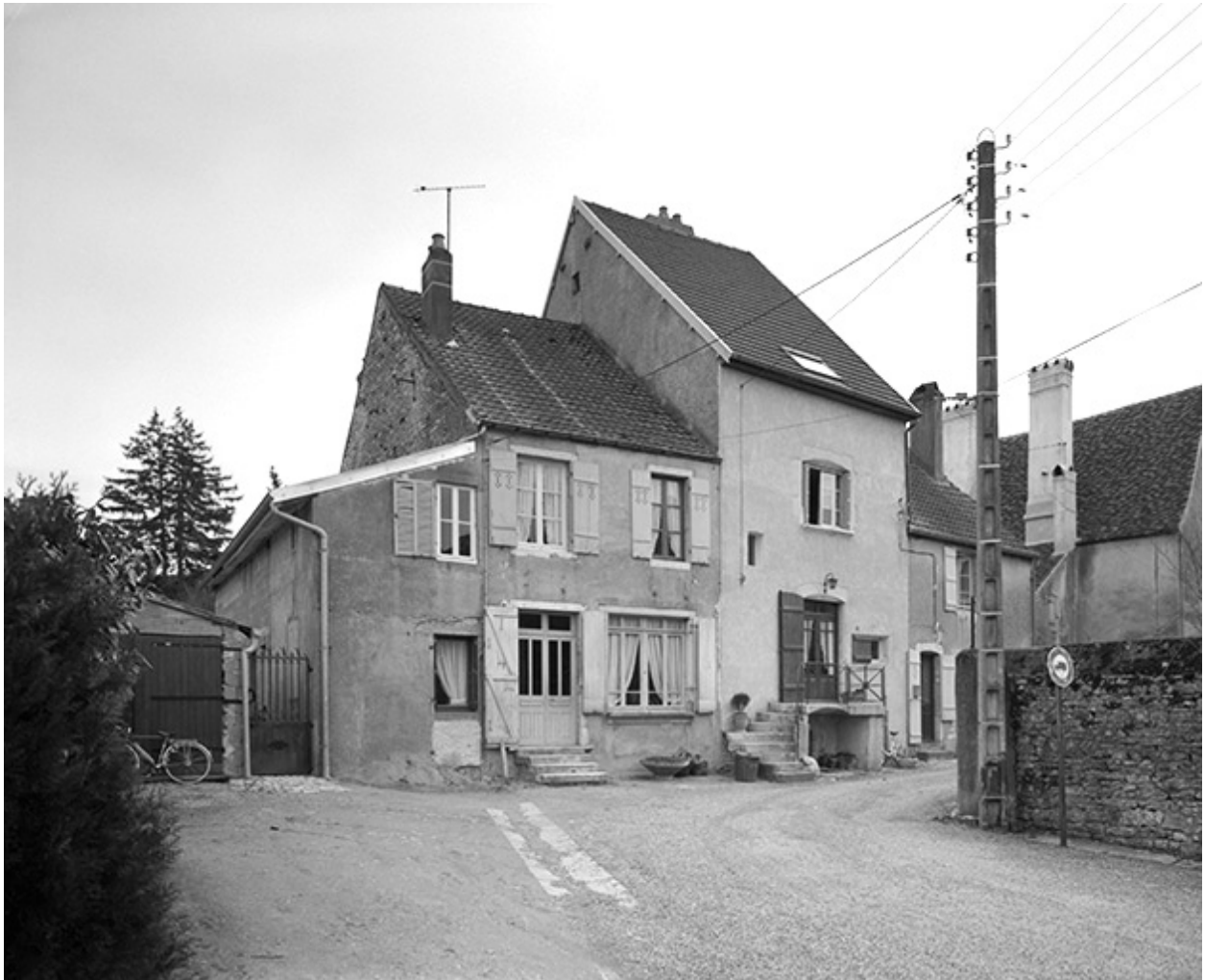
Maison située rue Sainte-Anne : vue d'ensemble.
