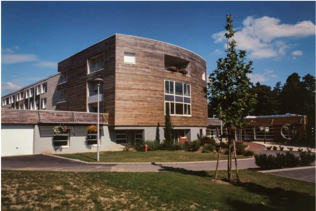
Maison de retraite, élévation antérieure.
