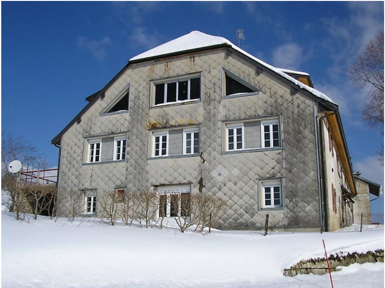
Vue générale du pignon sud-ouest.
