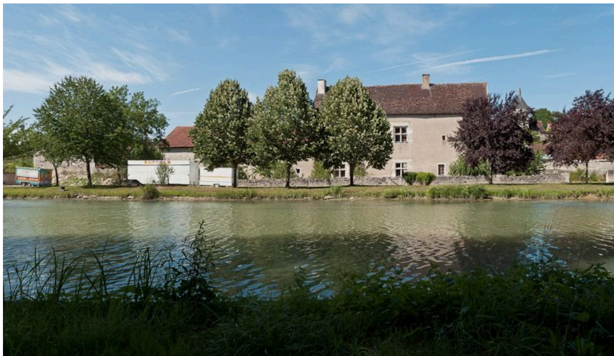
Vue d'ensemble du site depuis le canal.
